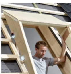
1 Element za ugradnju krovnog prozora, gornji dio
